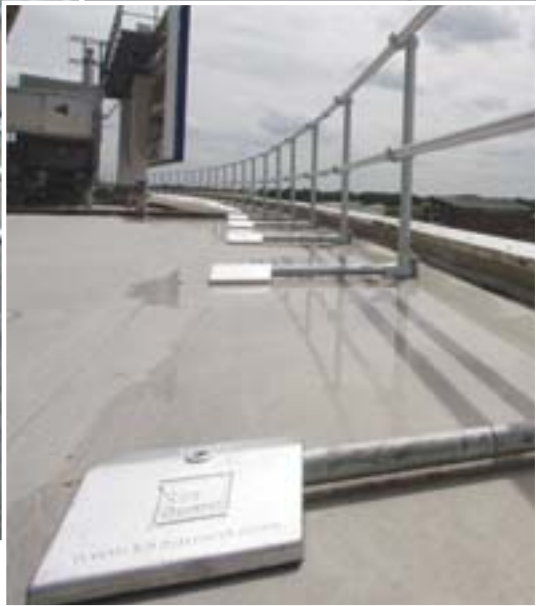
Undgå montage/fastgørelse i eksisterende tag
